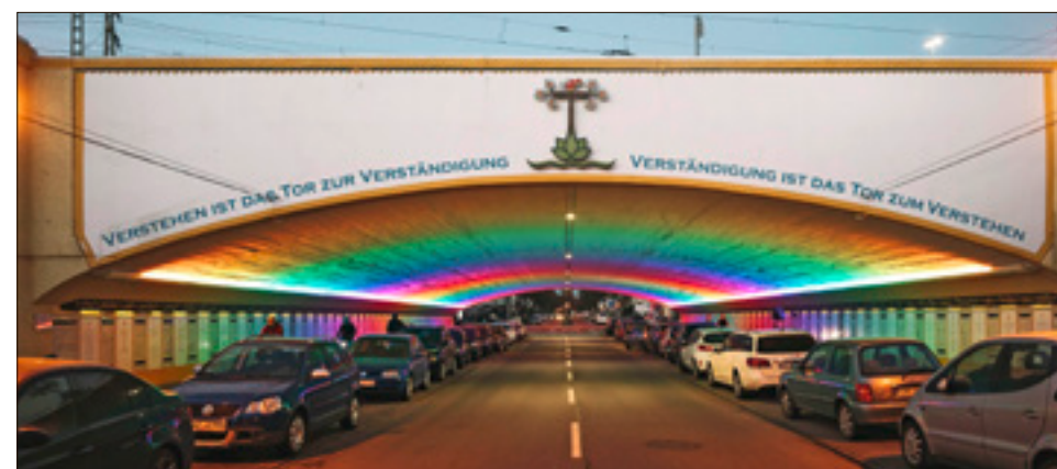
➤ Der zum Friedenstunnel umgestaltete Remberti-Tunnel nahe des Hauptbahnhofs wirbt für Vielfalt, Toleranz und Verständigung.
