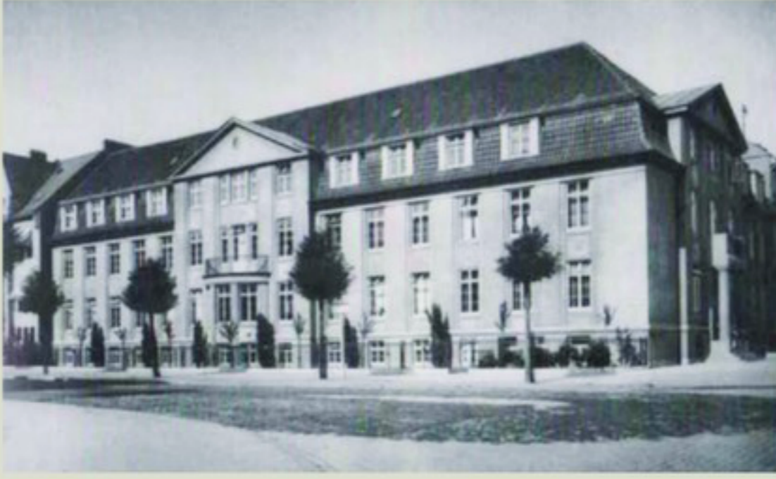
Parkallee 2: St. Catharinenstift Blick in die Hohenlohestraße In den 1990ern wurde das Gebäude um eine Etage aufgestockt. Quelle: Staatsarchiv Bremen
