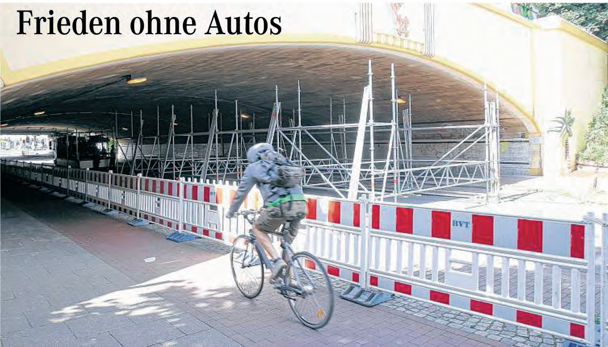
Die Innenarbeiten am Rembertitunnel gehen weiter. Bis 6. September ist die Bahnunterführung deshalb für Autos gesperrt. Fahrräder und Fußgänger kommen auf einer Seite durch. FOTO: PETRA STUBBE
