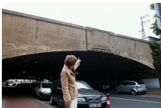
Rembertitunnel im Jahr 2001
