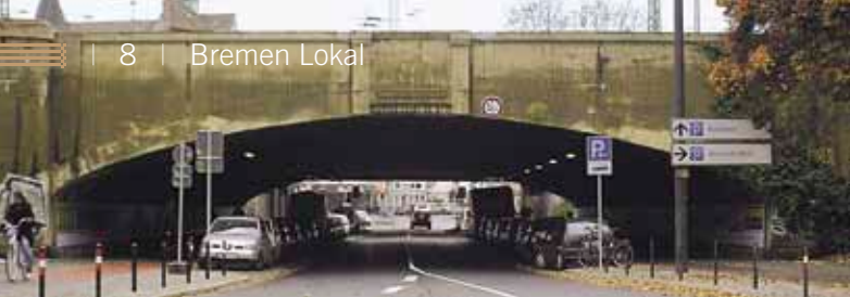
So sah der Remberti-Tunnel vor der Umgestaltung aus.
